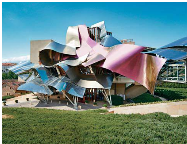
Bodegas Marqués de Riscal Haro, La Rioja (Испания)
